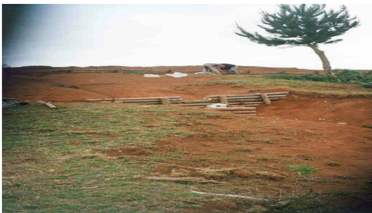
Figura N° 8: Dique de Postes de Madera (Fuente: CONAF, 1999)
