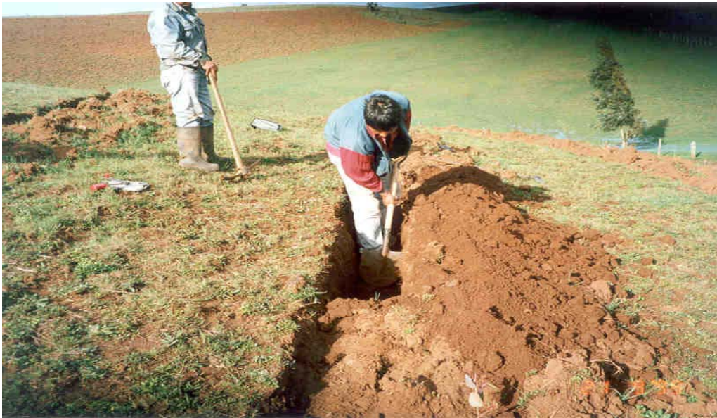
Figura 14 Construcción de Zanjas de Infiltración.(Fuente: CONAF, 1998)
