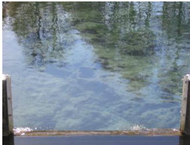
Figura 3. Lodo acumulado en la piscina de sedimentación
