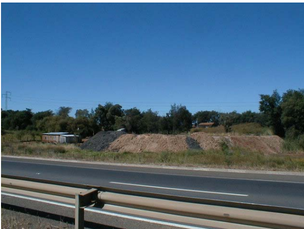
FIGURA N° 9.702.302(2).B ABANDONO INADECUADO DE BOTADERO
