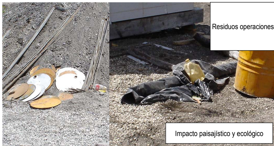
FIGURA N° 5 (CONTAMINACIÓN DE SUELO)
